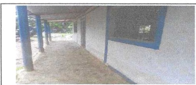
Foto 4: El piso de la escuela esta en mal estado y se necesita remozar toda la escuela.
