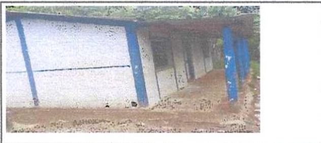
Foto 2: Mantenimiento de paredes deterioradas
